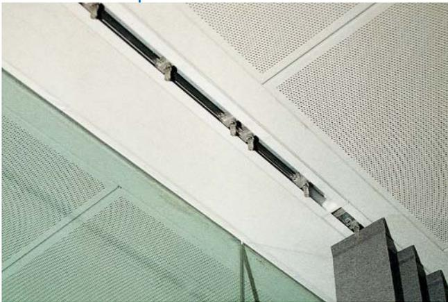
**KR-S** Langfeld-Metall-Akustik-Kühldecke mit Vorhangschiene und Glasanschlußleiste
