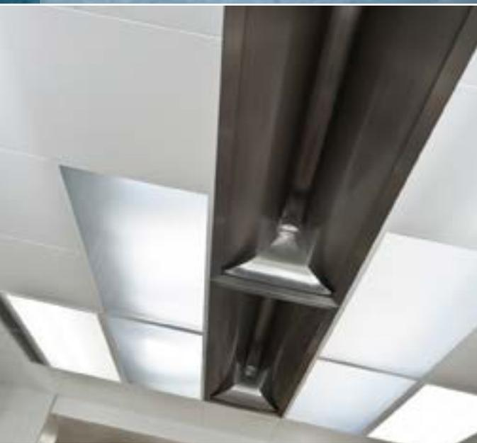
Die Extractoren sind über den thermischen Küchengeräte positioniert. Hierbei werden die Abluftmenge und die Größe der Extractoren auf die installierten Küchengeräte abgestimmt. Die Luftmengen werden nach ÖNORM, DIN EN16282- bzw. VDI-Richtlinien berechnet.
